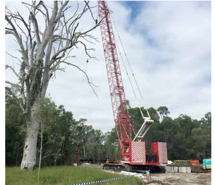
Mobilisation of 180 tonne crane
